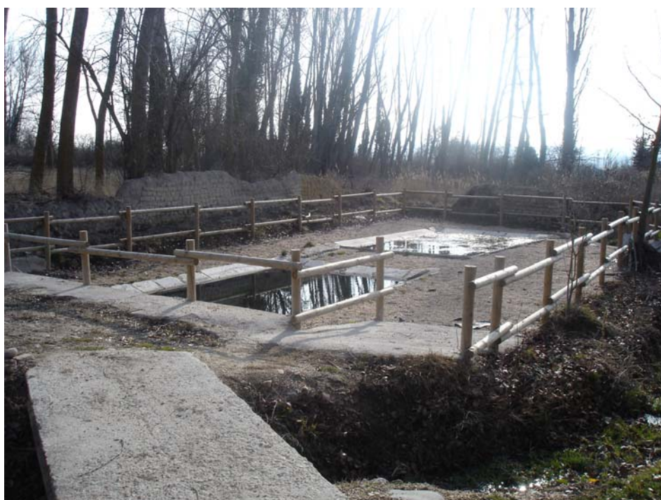
Fotografía 16: Lavaderos en la parte Norte del Caco Urbano.
